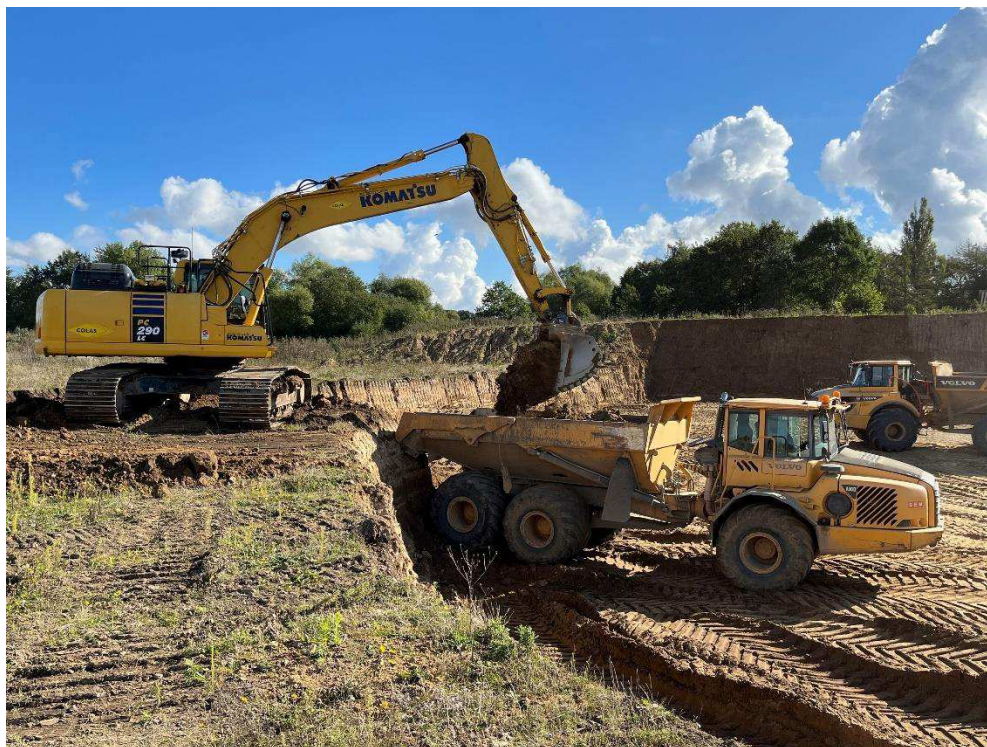
Figur 1 viser afrømning af muld og overjord med gravemaskine og dumper
