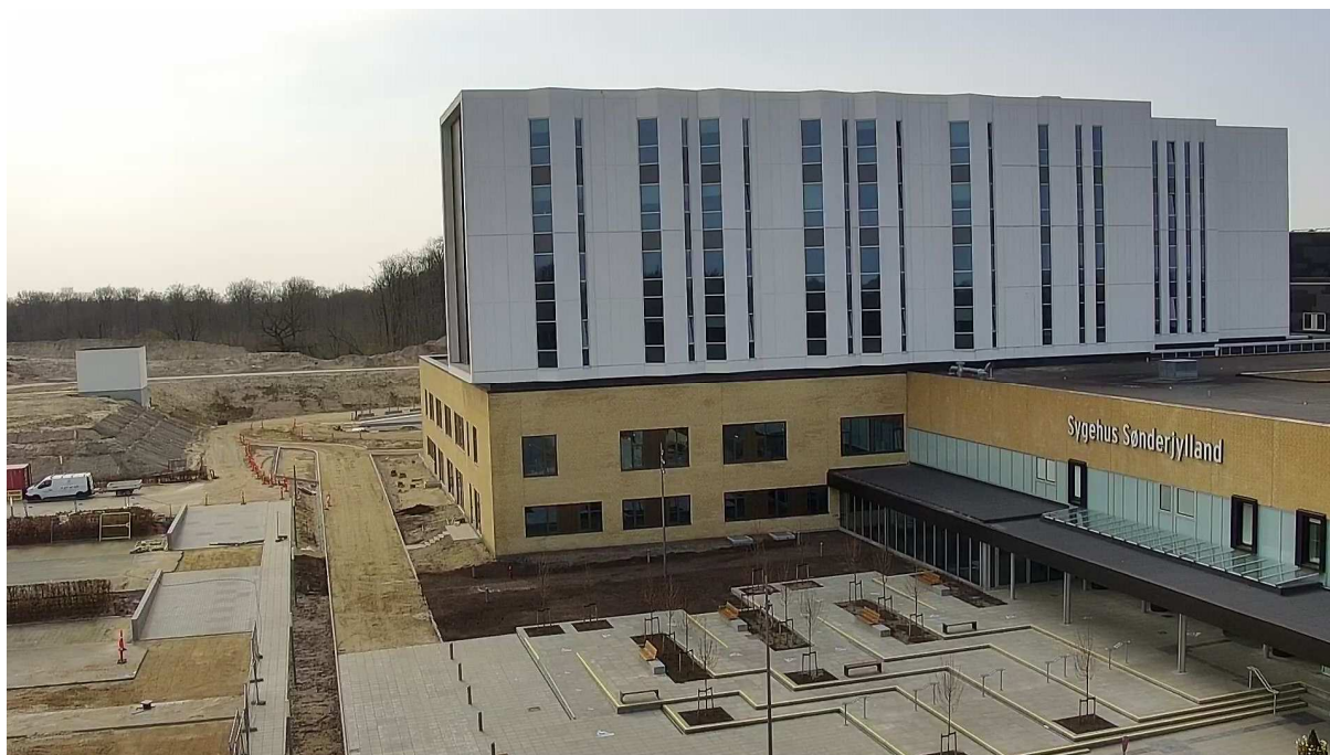
Øverst: Den nye forplads ved Indgang A. Nederst: Anlægsarbejderne skrider frem.
